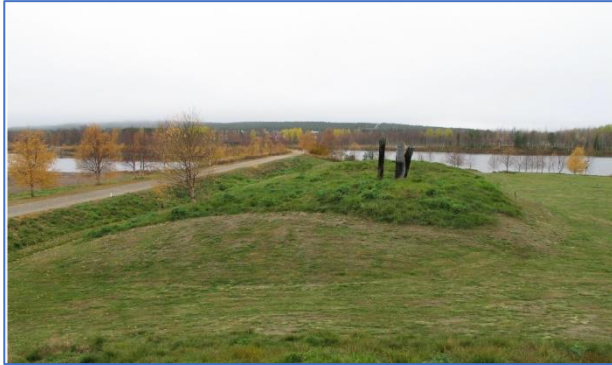
Kuva 2. Pöyliöjärven maapato (kuva: Kemijoki Oy).
