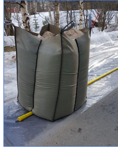
Kuva 6. Suurhiekkasäkin tiivistäminen maata vasten.
